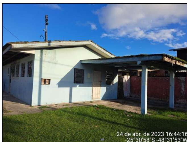
Figura 48 - Associação de Moradores do Bairro Serraria do Rocha.
